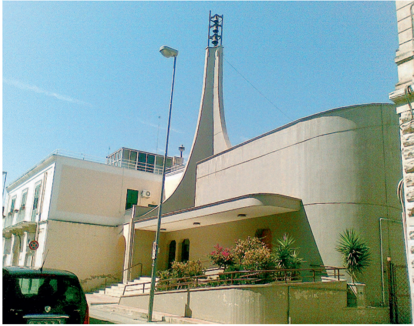
ASSISTENZA La casa di riposo Storelli adiacente alla chiesa di San Silvestro
